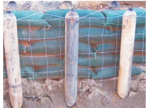
"Nährstoff-Falle" mit FerroSorp® GW (2 - 4 mm) in Filtersäcken
