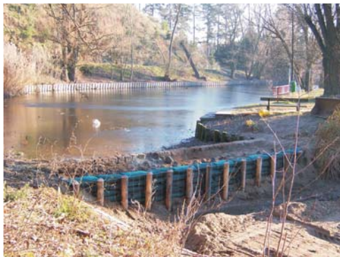
"Nährstoff-Falle" mit FerroSorp® GW (2 - 4 mm) in Filtersäcken
